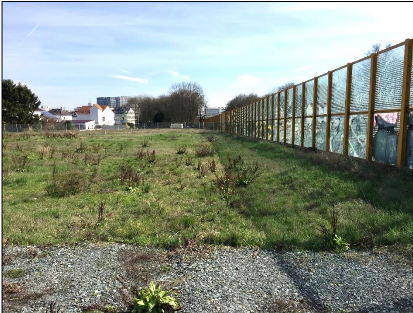
Abb. 15: Bestehende Lärmschutzwand zur Landesstraße 3005
