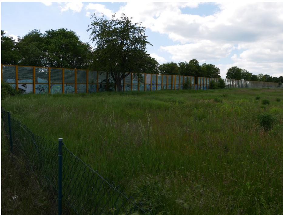
Foto 2: Blick auf die Lärmschutzwand sowie den Kirschbaum mit Rindenabspaltungen.
