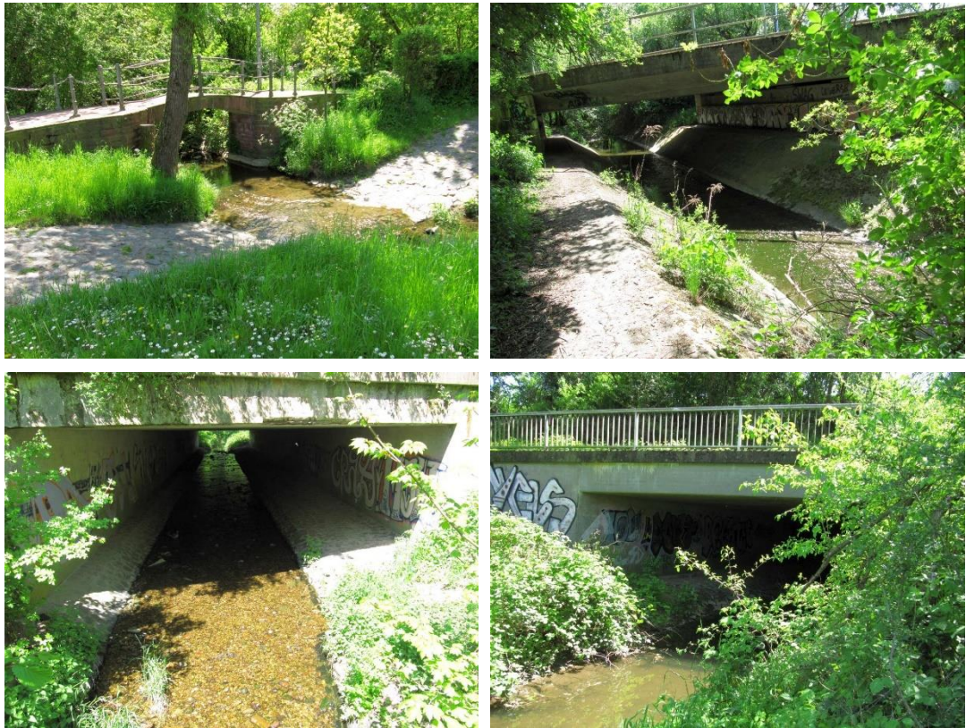
Abbildung 3.11: Fotos Querungen Bahnhof bis A66
