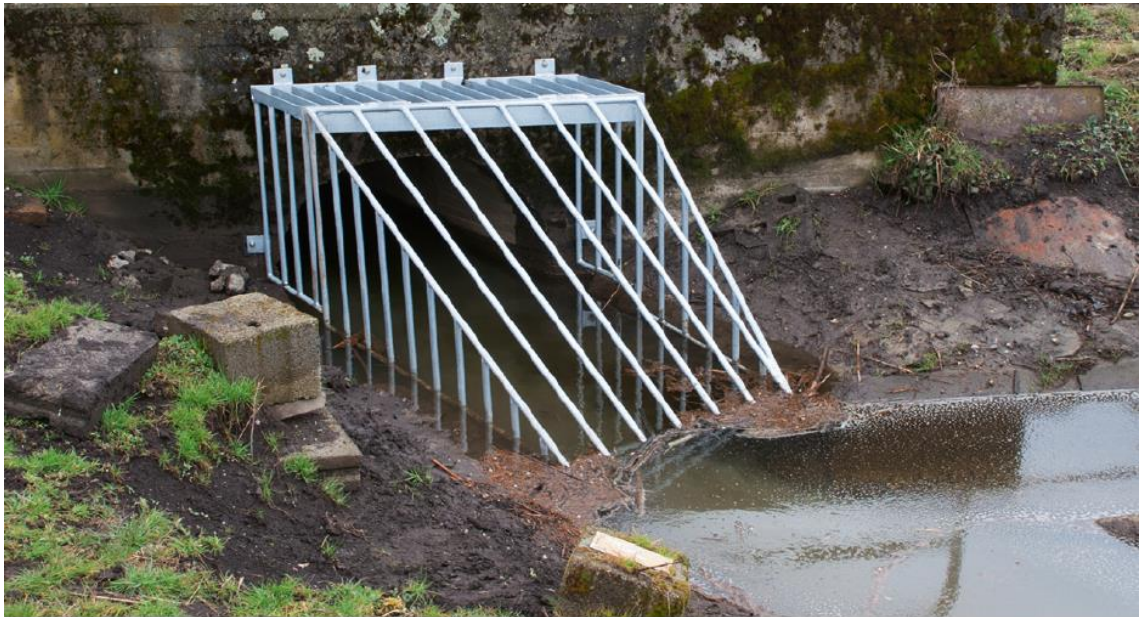
Abbildung 6.1: exemplarische Darstellung räumlicher Einlaufrechen (Quelle: LUBW 11 )
