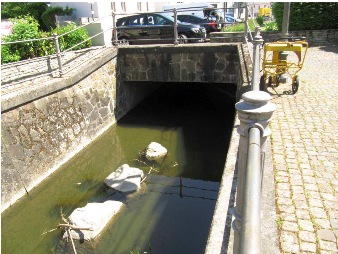
Abbildung 6.2: Zulauf zur Westerbachverrohrung in der Oberortstraße
