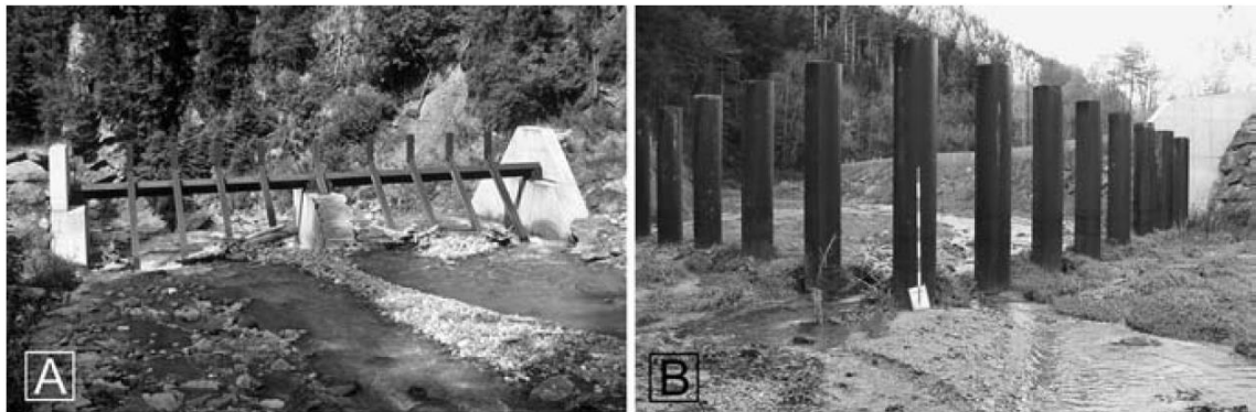
Abbildung 6.5: Wildholzrechen (A) und V-förmiger Wilholzfang (B) 4
