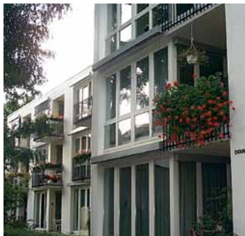
Das August-Mencke-Haus in der Hauptstraße 24
