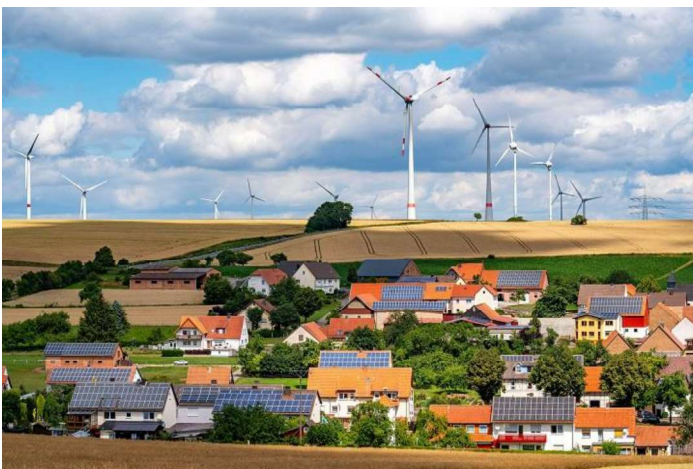
Photovoltaik im privaten Wohnbau
